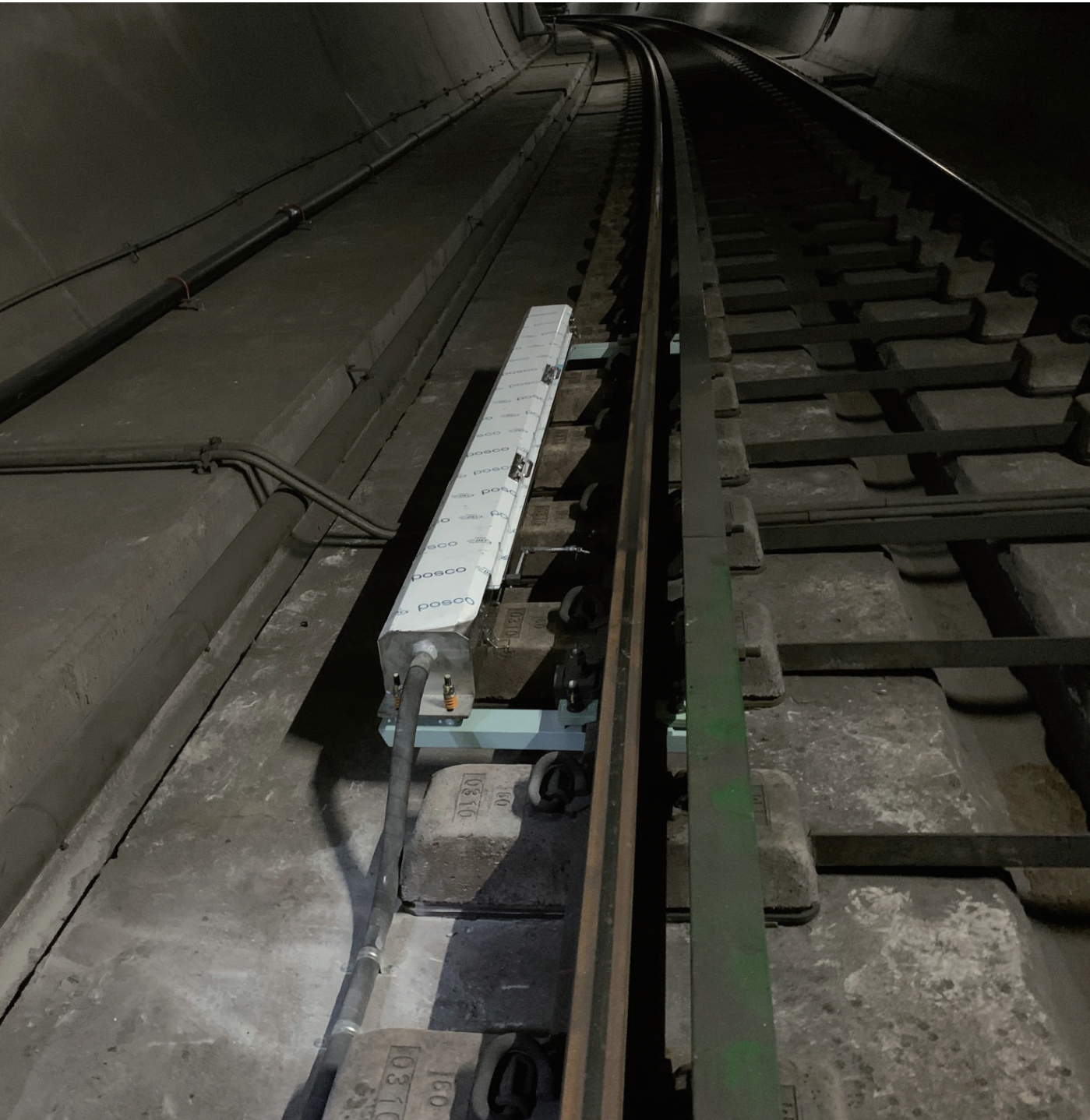
▲ 레일코팅시스템 설치 전경
